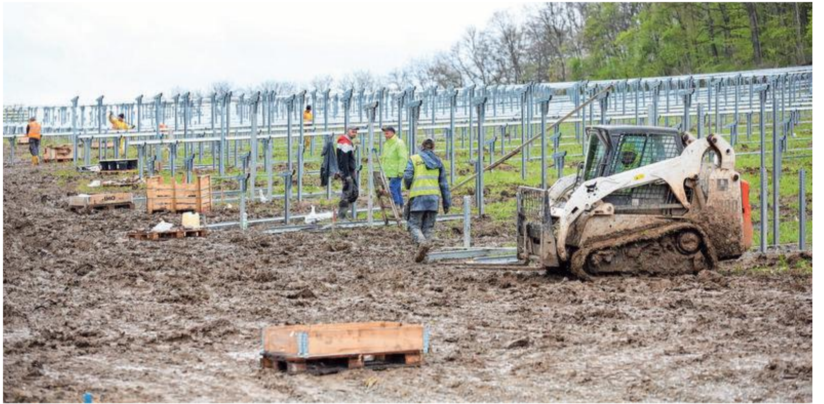
Durch den Regen war der Aufbau des Solarfelds bislang eher eine schlammige Angelegenheit.
